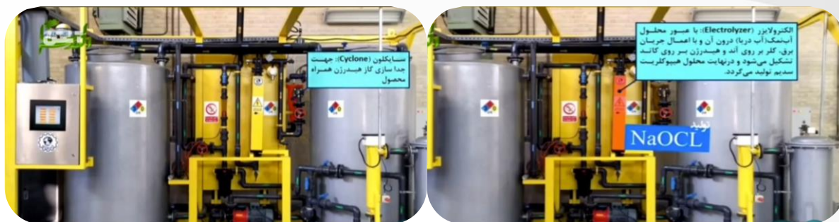
۲ - واحد الکترولایزر و موقعیت قرارگیری جداساز فعلی (هیدروسیکلون)
